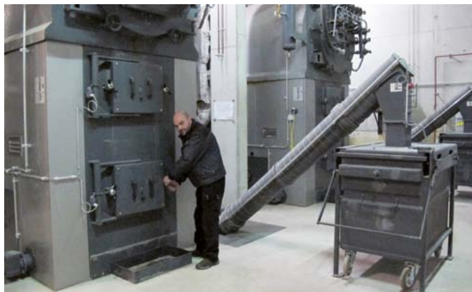
Bruno Leuenberger von der Atlantis AG betreut die 2200 kW starke Holzschnittelanlage, die sich im Untergeschoss der Überbauung Wägelwiesen befindet.
