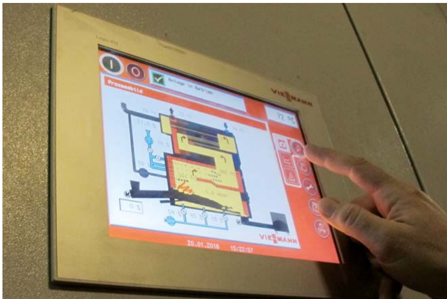
Das Steuerungsdisplay zeigt den Verlauf des Heizprozesses.
