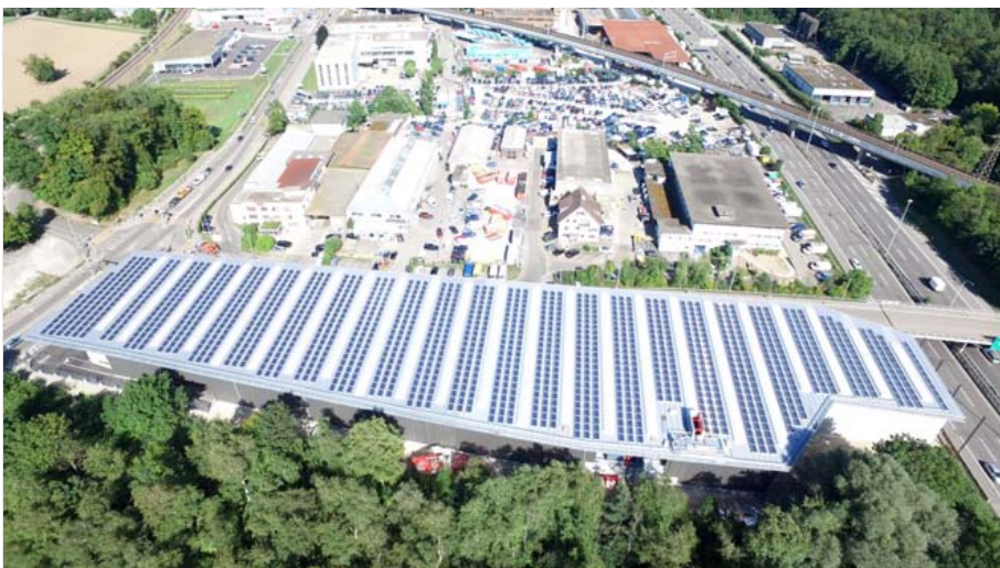
Auf der gesamten Dachfläche des Neubaus der K. Müller AG befindet sich die von die werke betriebene Photovoltaikanlage.
